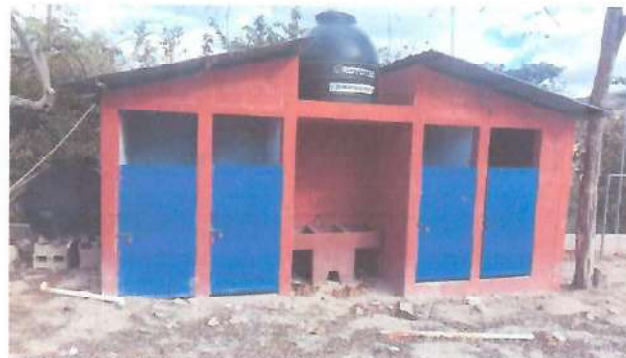
Foto 2: Mejoramiento de cubierta de lamina de baños
