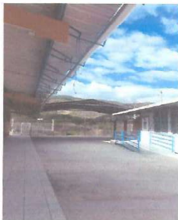
Foto 1: Mejoramiento de cubierta de lamina
