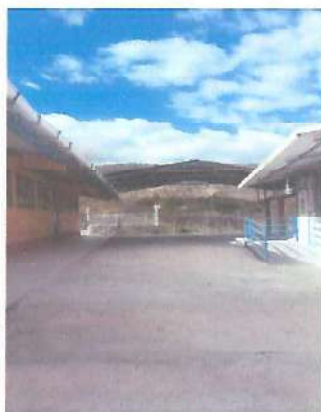
Foto 3: Mejoramiento de cubierta de lamina
